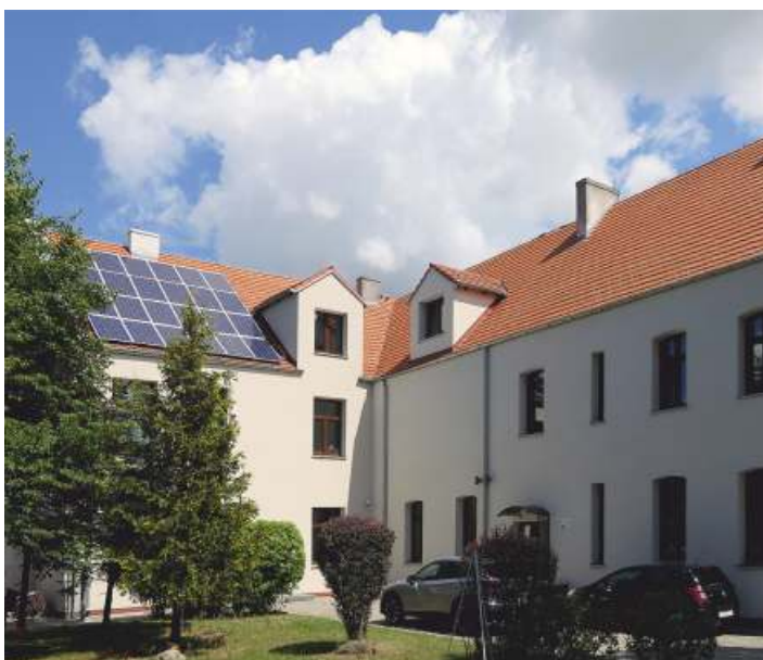
Termomodernizacja Szkoły Podstawowej w Orłowie
