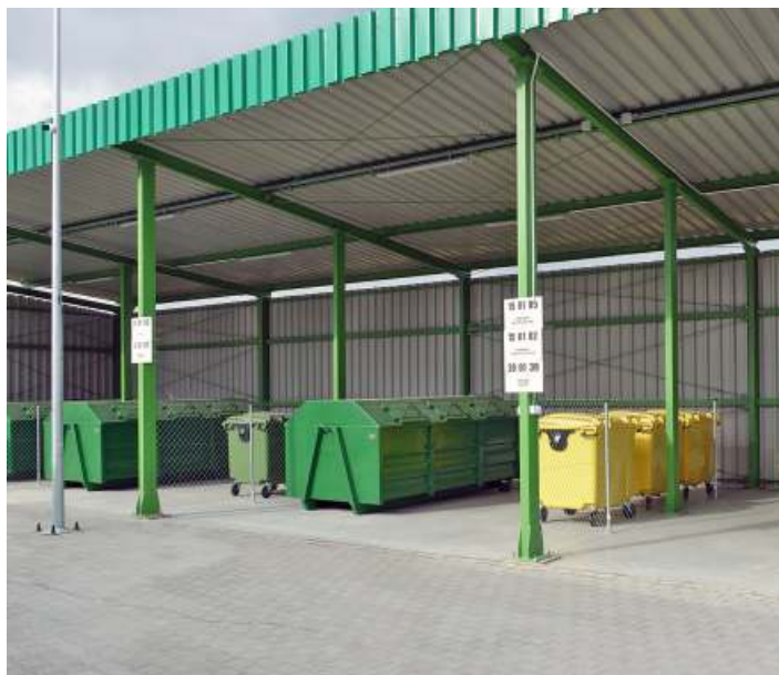
Punkt Selektywnej Zbiórki Odpadów Komunalnych w Kruśliwcu
