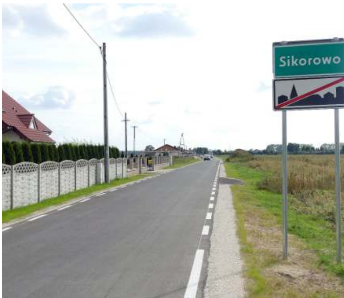
Przebudowa drogi w Sikorowie
