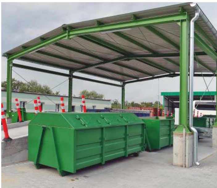
Punkt Selektywnej Zbiórki Odpadów Komunalnych w Kruśliwcu
