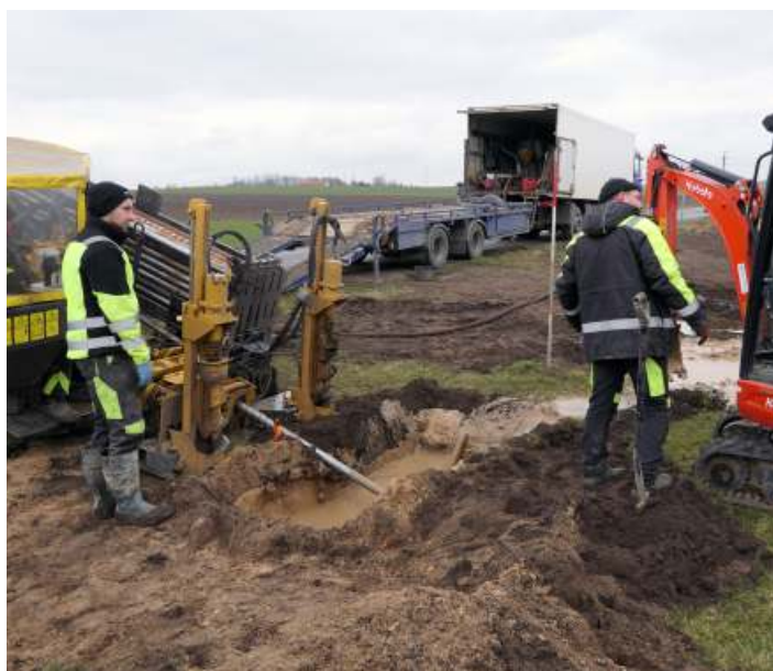
Rozbudowa kanalizacji w Miechowicach
